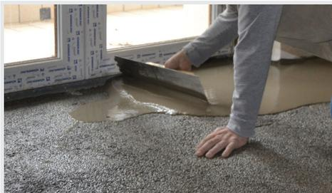
**Vorbereitung:** Die Stützen müssen fest, konsistent, gut gewürzt und frei von abnehmbaren Teilen sein, die von Staub, Fett, Ölen, Farben und Wachsen gereinigt sind. Die Gips- oder Anhydritsubstrate sowie die vorgefertigten Platten müssen trocken, kompakt und staubfrei sein. Vor dem Glätten mit **Planilevel Livellina** ist es wichtig, solche Oberflächen vorher mit **PRIMER GS** zu behandeln. Risse und Risse müssen mit Eposan versiegelt werden.
