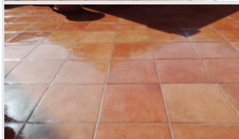
Miscelare bene **Scudolastic T** e versare sulla superficie previo trattamento con **Primer Gres**, applicandolo con un rullo di lana mohair o pennello, per l'intera superficie con dosaggio di 60/70 gr/mq.
