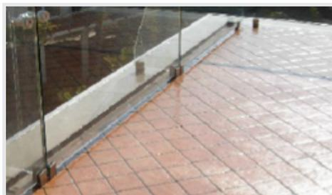
**Scudolastic T** è una membrana trasparente in poliuretano monocomponente, alifatica, dotata di buona elasticità e con un alto contenuto di residuo secco, utilizzata per un' impermeabilizzazione a lunga durata. Grazie alla propria struttura è stabile ai raggi UV, per cui nel tempo non ingiallisce.
