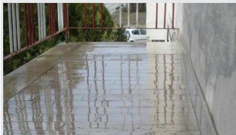
Pulire accuratamente la superficie da trattare rimuovendo olio, grassi, e saponi contaminanti. Rimuovere i sali superficiali del cemento, i particolati non aderiti, agenti chimici rilasciati dagli stampi, membrane ritardanti di evaporazione del cemento e riempire le irregolarità del supporto con i rasanti idonei della gamma Opera.
